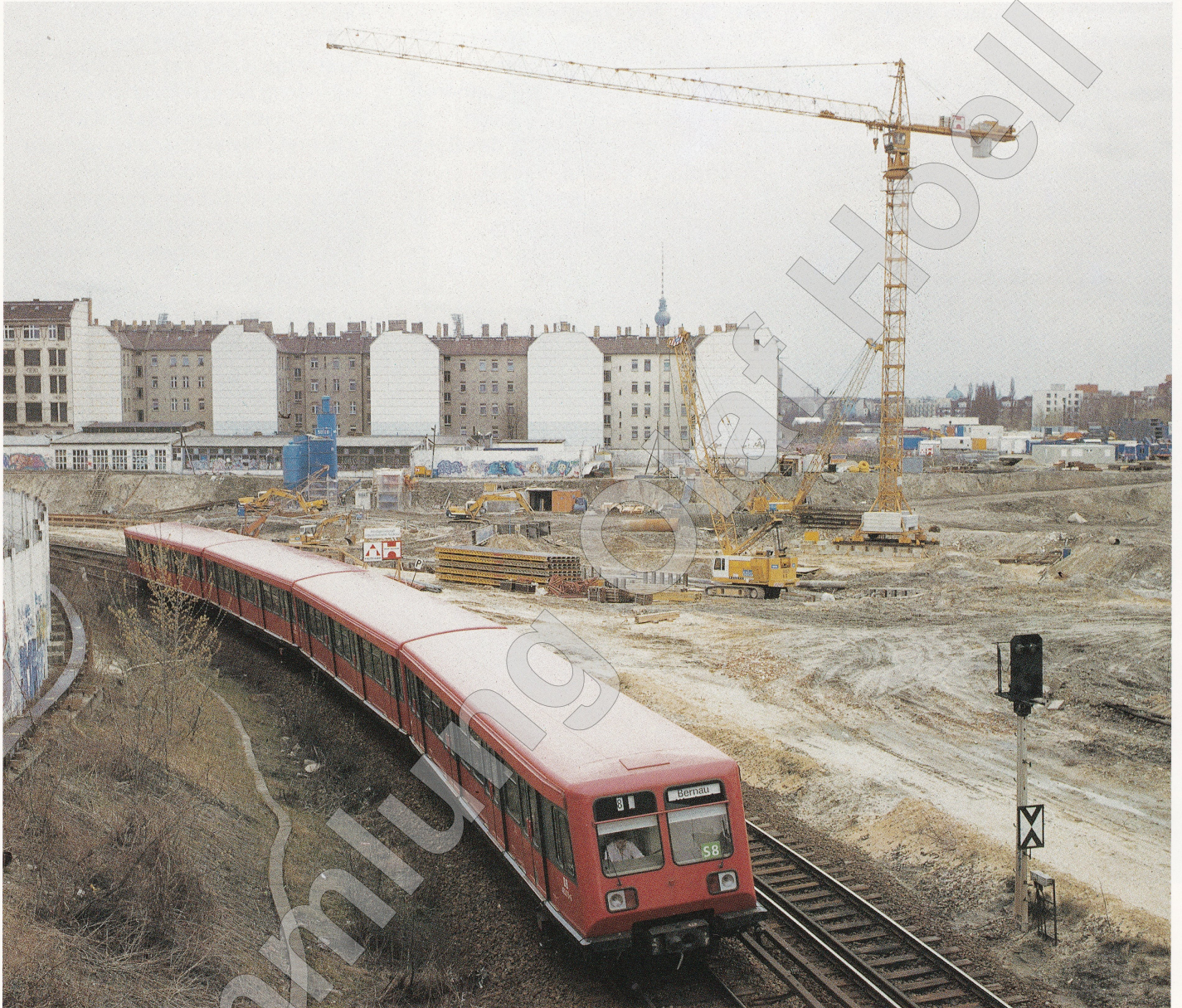
Der Neubau des Nordkreuzes ist eine der größten Baustellen des Berliner S-Bahn-Netzes
